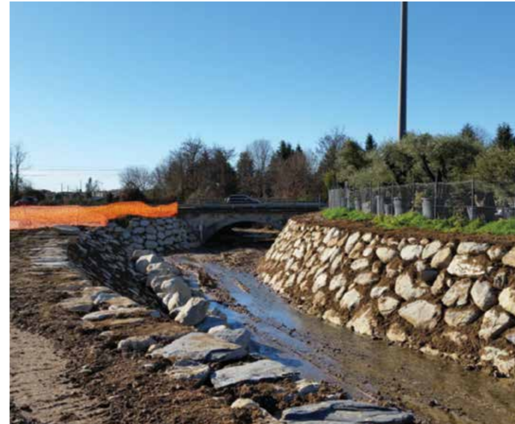
A sinistra: vista delle opere di risagomatura alveo del torrente Lesina
