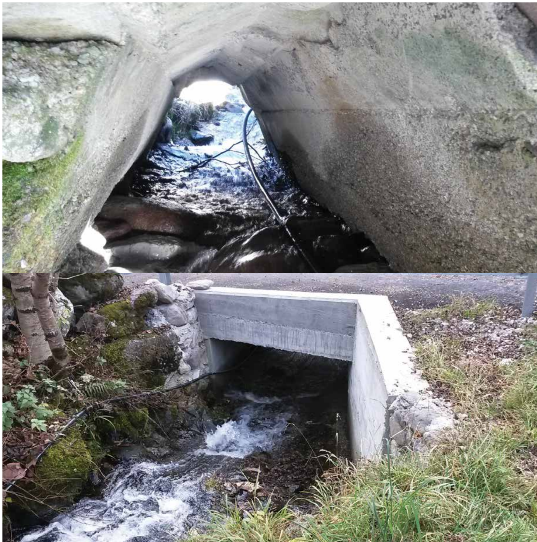
In alto: "Tombotto" sottopasso stradale "Valle Bigarola" in Comune di Ardesio
